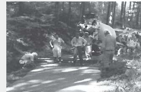
林道のコンクリート舗装
