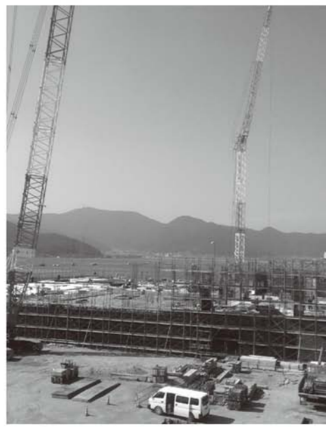
建設中の西予市民病院(H25.11月時点)
