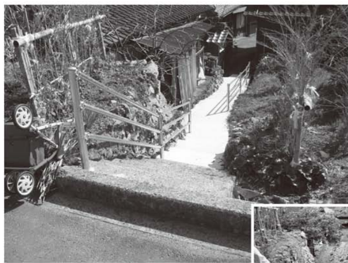
手すり等の避難路を整備
