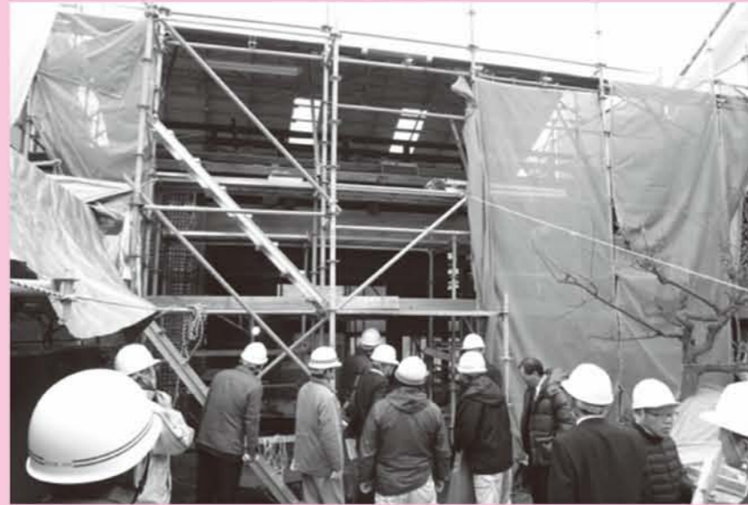
鳥居門修復工事を視察
