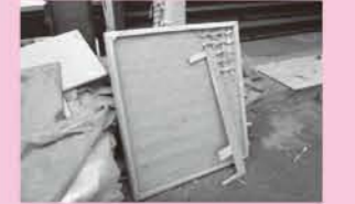
撤去した土壁を再利用
