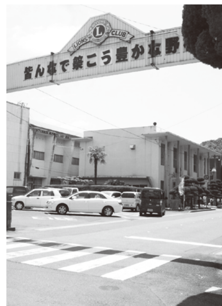
老朽化した公共施設（野村町）
