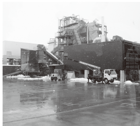
木質バイオマス発電施設（会津若松市）
