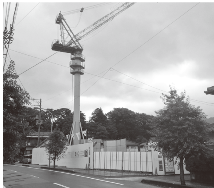
建設中の愛媛県オフサイトセンター(宇和町)
