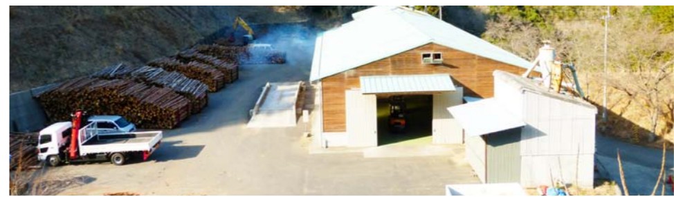
バイオマスペレット製造工場(城川町)
