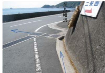
用悪水路の現状(三瓶町)
