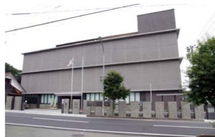
完成したオフサイトセンター(宇和町)
