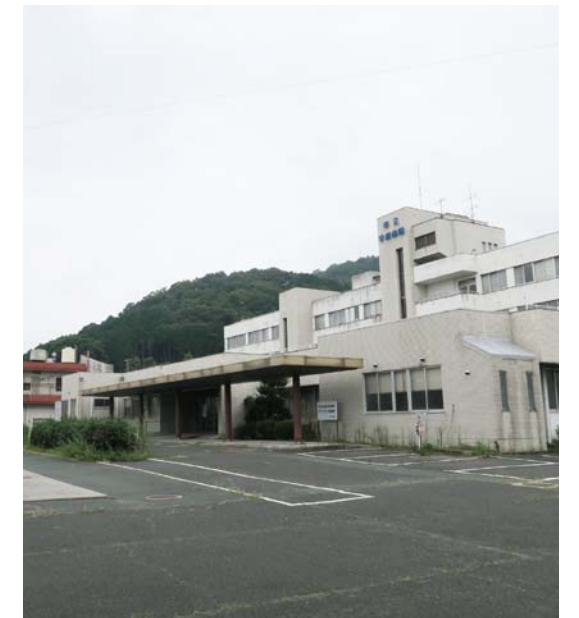
解体が待たれる旧宇和病院
