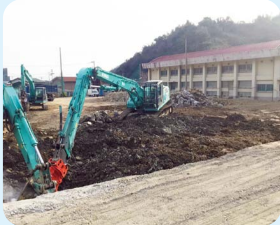
校舎解体工事現場 (明浜)
