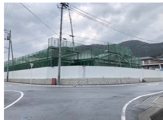
宇和病院跡地に建設中の公共施設
