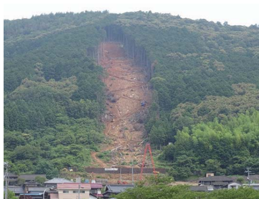
災害復旧工事の進捗状況 (明間四道地区)
