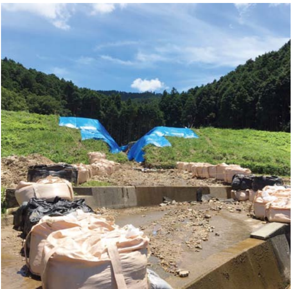
6月の大雨による災害 フケ下池堤体決壊(宇和町大江)
