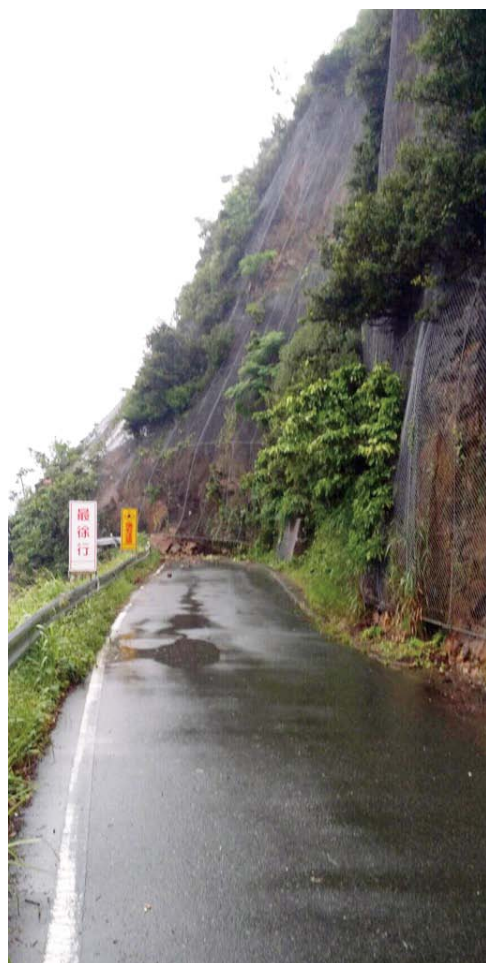
がけ崩れ発生現場(明浜町岩井地区)
