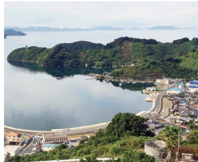
本年度完成予定の俵津工区
