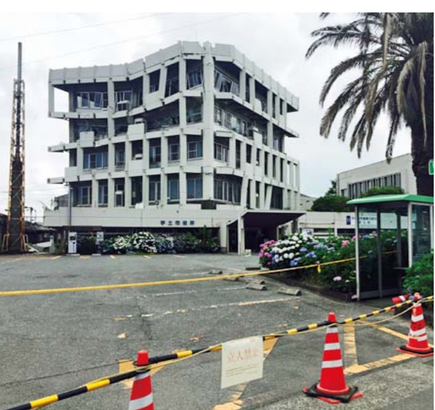
熊本地震で倒壊した宇土市役所(熊本県)
