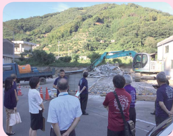
西予市地域共生型交流拠点施設建設予定地(三瓶)
