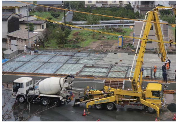
建設中の地域共生型交流拠点施設
