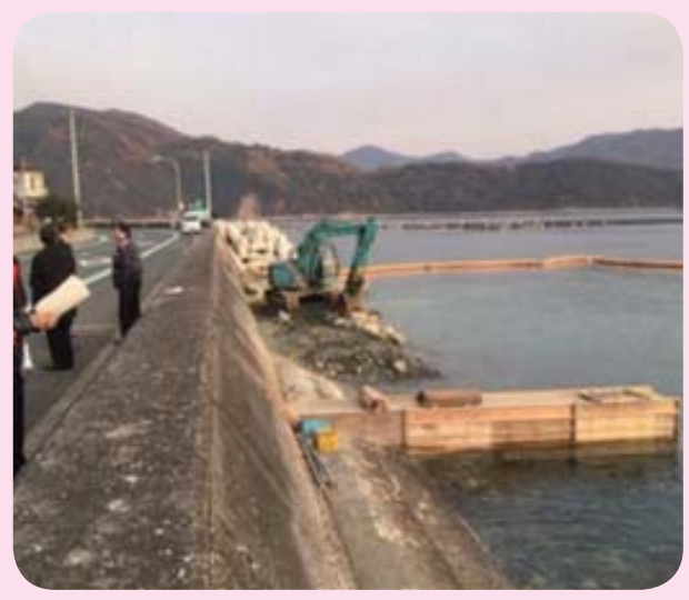
高潮対策工事（長早漁港）
