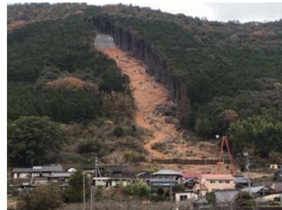
災害復旧現場（宇和町明間）
