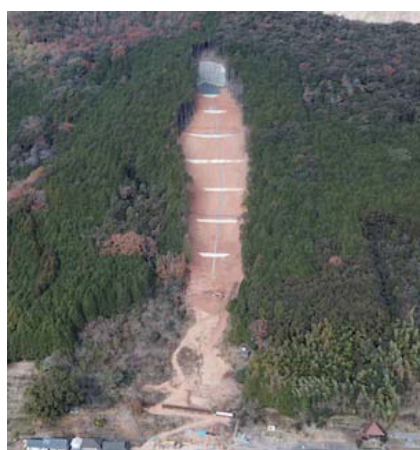
明間四道地区の災害復旧工事現場
