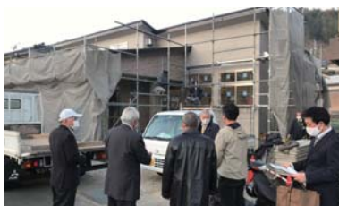
あした建設中の明下田クラブ（宇和町皆田）
