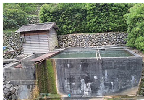
農業用貯水槽（明浜町）
