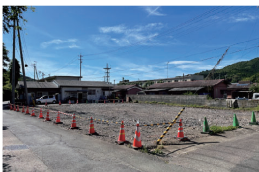
整地中の市営住宅建築予定地（宇和町）
