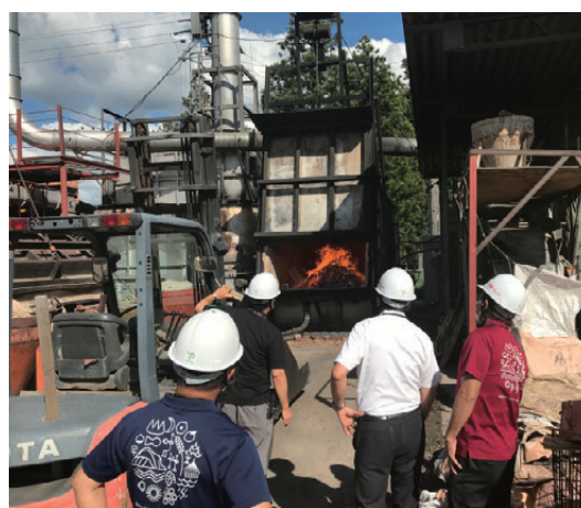
間伐材を燃料とする発電所
