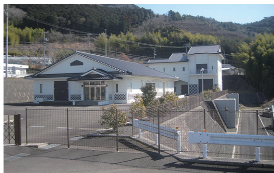
公共下水道宇和浄化センター（宇和町）
