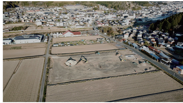
西予市消防本部新庁舎造成地（宇和町）
