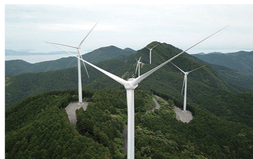
再生可能エネルギー（風力発電）
