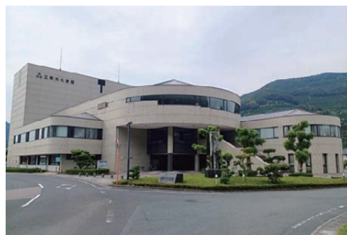
空調設備不良の三瓶文化会館
