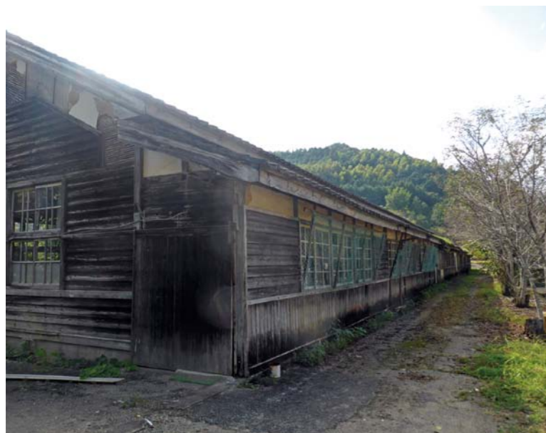
解体予定の旧中筋中学校舎(野村町)
