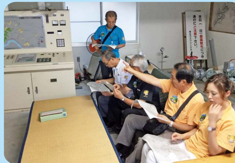
三瓶南1ブロック制御室(三瓶町)
