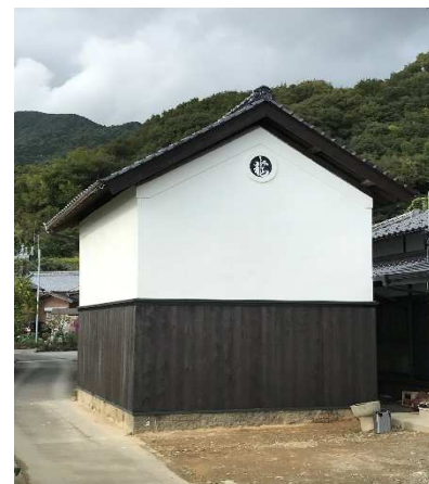
H家蔵（重要文化的景観、修理後）
