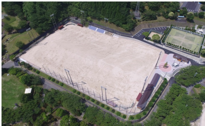
宇和運動公園多目的広場 整備状況
