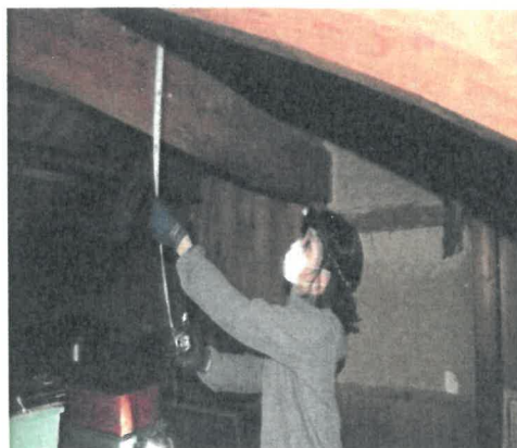
家屋調査の様子(平成29年4月)
