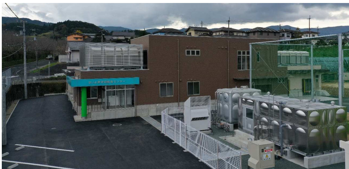
完成したせいよ東学校給食センター
