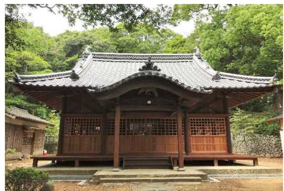
春日神社拝殿（重要文化的景観、修理後）
