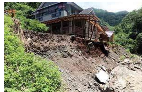
土砂災害で家屋の基礎が露出
