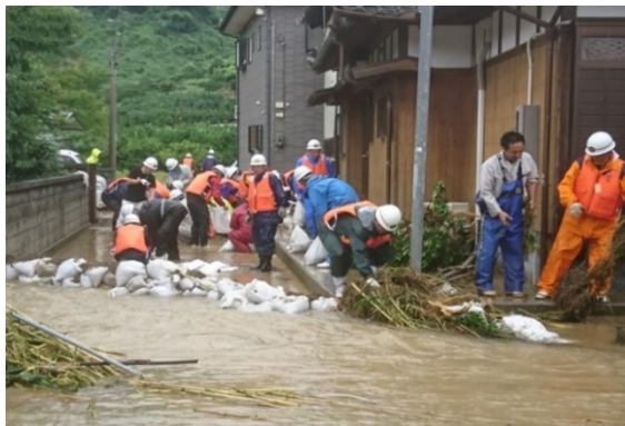
土嚢積み (7/7 明浜町俵津で撮影)
