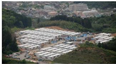
市内で最大の規模となった 長洞応急仮設住宅
