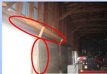
柱・梁の歪みの補修、補強
