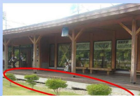
沈下した基礎部の補修、補強
