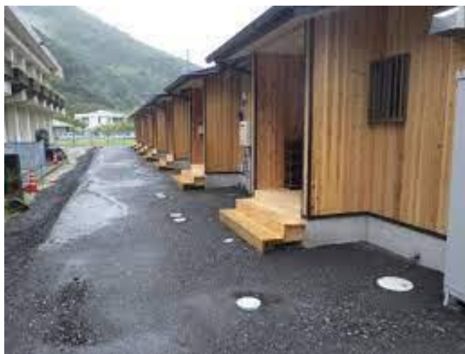
図 3-18 西予市の応急仮設住宅
