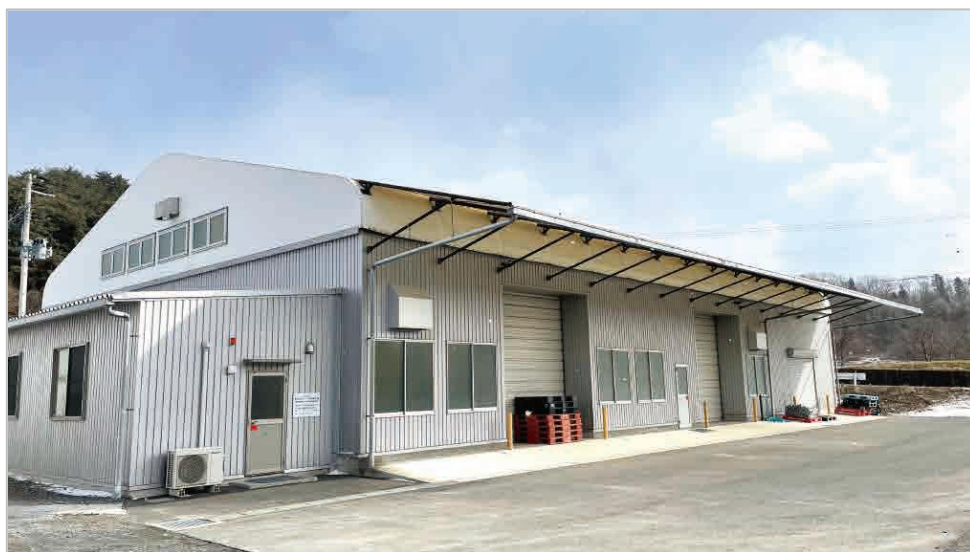
移転復旧した菌床しいたけ栽培施設(日頃市町)
