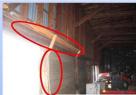
柱・梁の歪みの補修、補強
