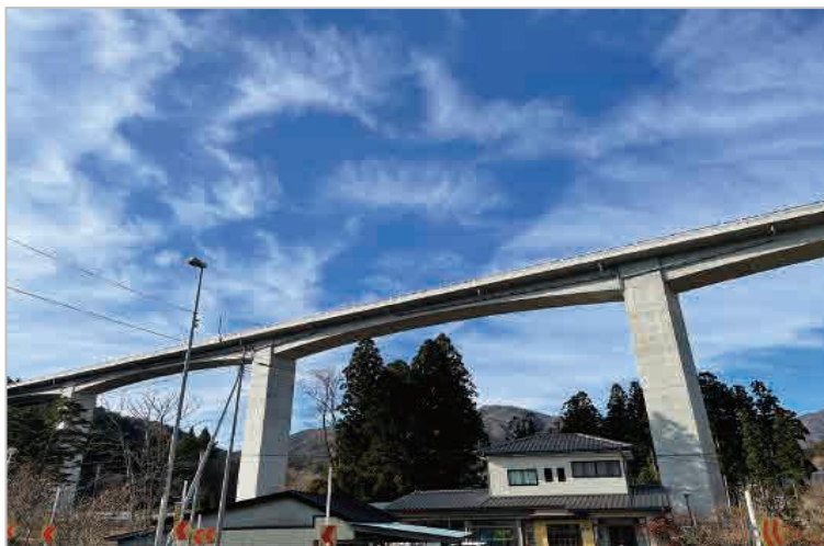
新たに整備・開通した三陸沿岸道路
