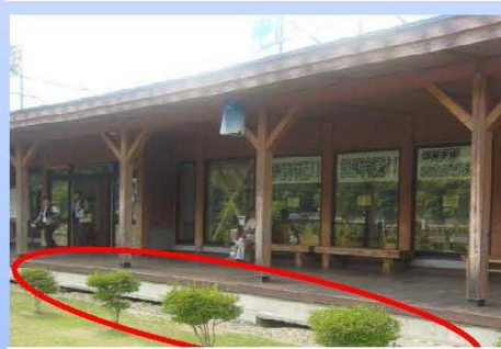
沈下した基礎部の補修、補強
