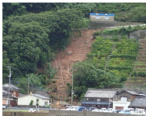
急傾斜地の崩壊（宮野浦第 1 号線農道）
