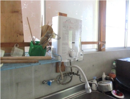
給湯器への接続がゴム管(左)から金属製(右)に更新
