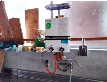
給湯器への接続がゴム管(左)から金属製(右)に更新
