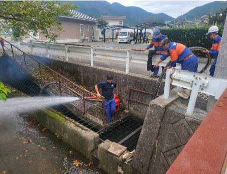
消防団と連携し防火水槽の土砂を除去
