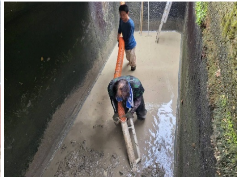
消防団と連携し防火水槽の土砂を除去
