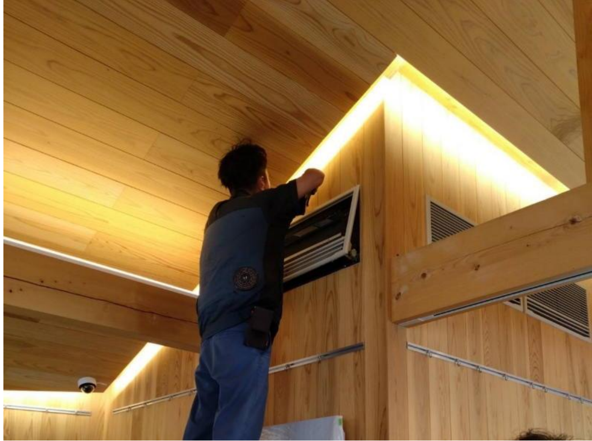
空調内の点検
