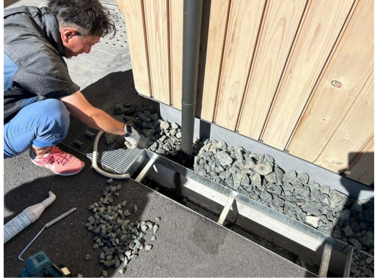
ドレン内の詰りの除去
