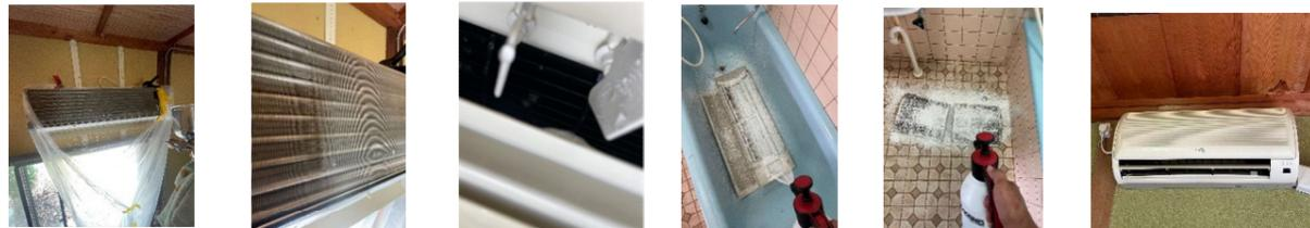
パネルを外して内部を洗浄 熱交換器部分 ファン・ルーバー パネルも丸洗い フィルター除菌洗浄 匂い解消、冷却効率復活！
