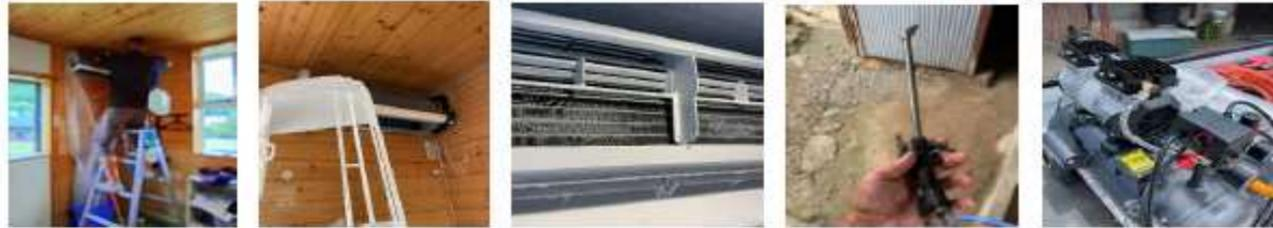
エアコン内部を薬剤で洗浄 カバーも丸洗い 熱交換器部分もしっかり洗浄 エンジンクリーナー エアコンプレッサー
