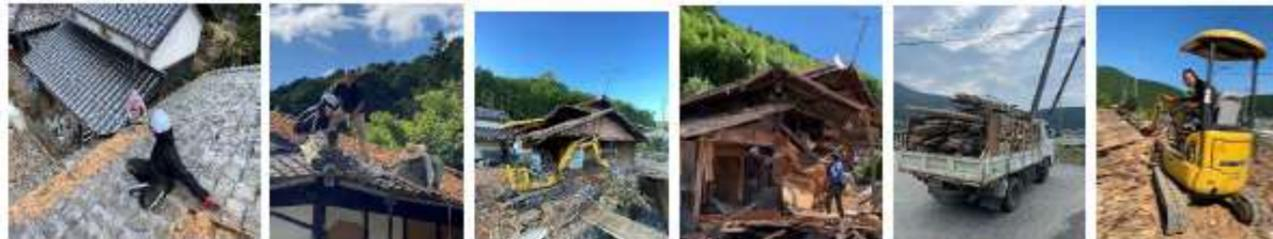
内装・建具等除去後、瓦を手作業で剥がします 地元の先輩方には大変お世話になっています 解体材は野村のグリーンガーさんに持ち込み
