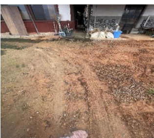
土が露出していた母屋前
