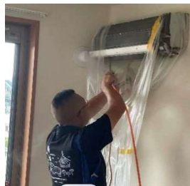
家庭用壁掛けエアコン清掃
