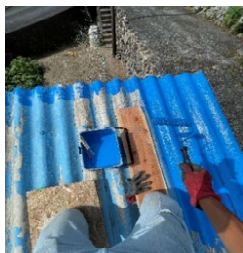
倉庫屋根塗装
