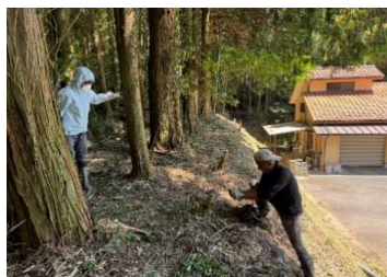
法面の雑木・竹伐採
