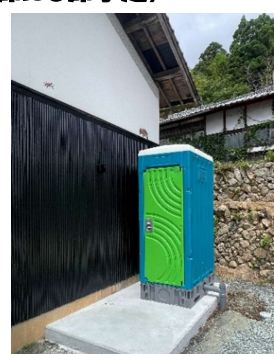
トイレは水洗式仮設を常設
