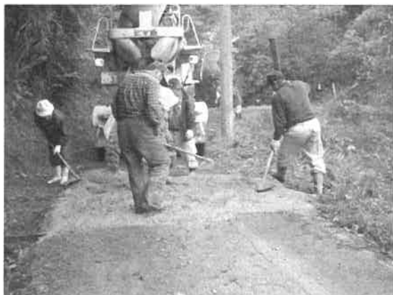
生活道補修作業
