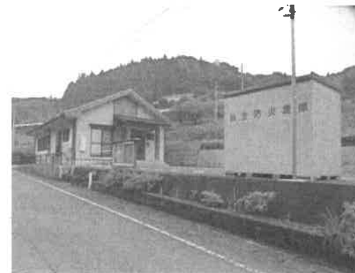
防災倉庫の設置
