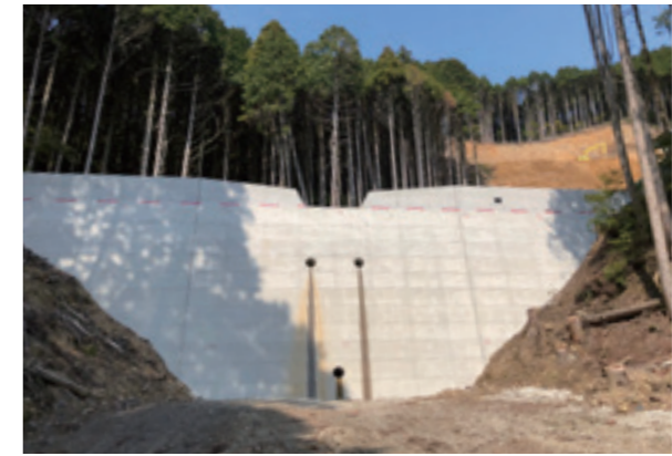
完成した治山ダム
