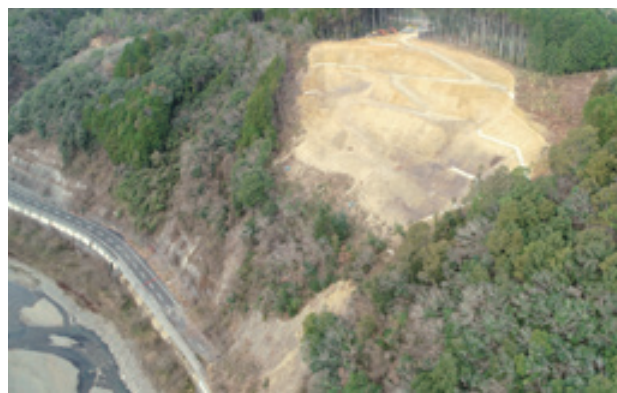
現在の復旧状況（令和3年12月末時点）
