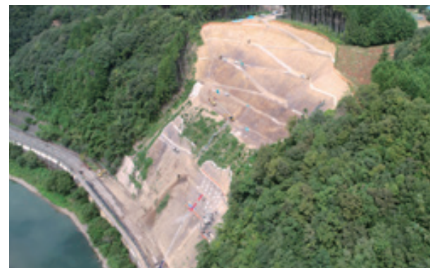
工事の進捗状況（8月末時点）
