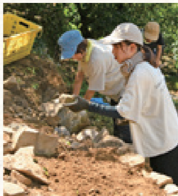
大きな石の間に「グリ」と呼ばれる小さな石を詰めて、石垣を積み上げていく
