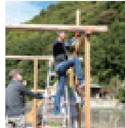
御旅所組み立て作業
