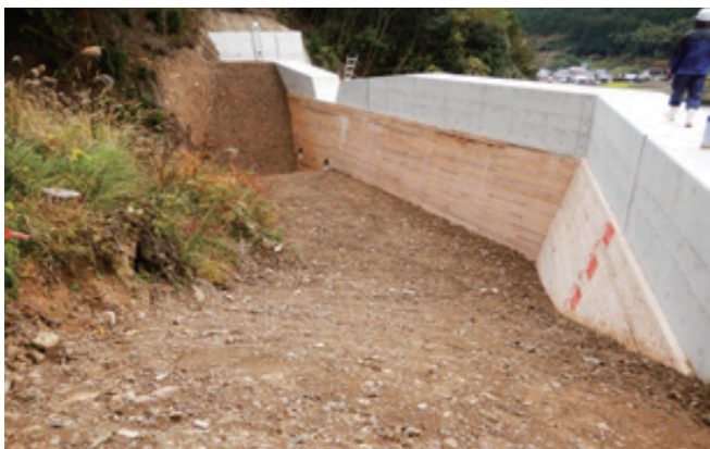
完成した1号谷止工
