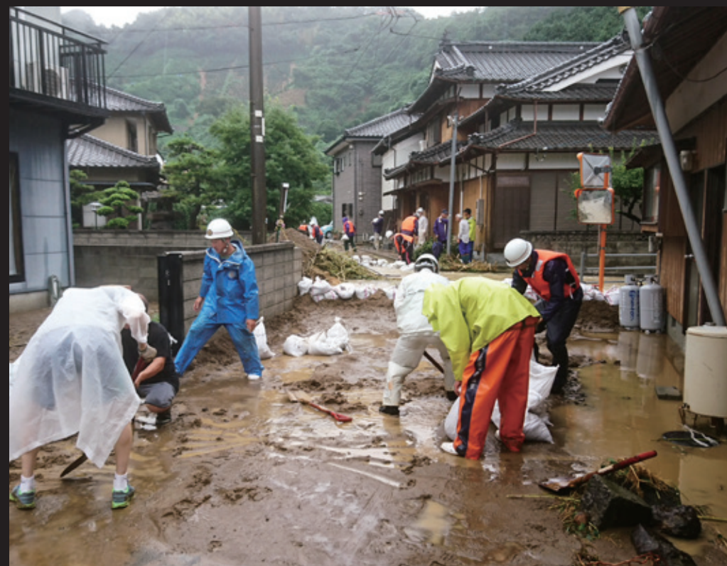
西予市消防団明浜方面隊俵津分団と、地区住民による復旧作業。 (明浜町俵津大浦)
