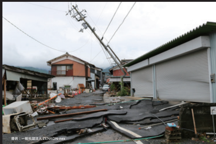
電柱は倒れ、路面はめくれ上がる。
