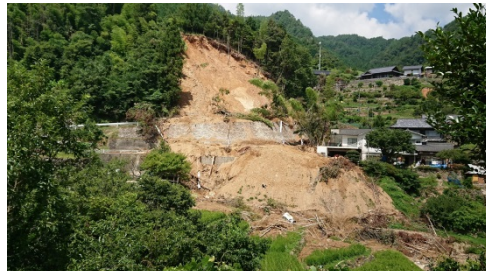
土砂の崩落（河西）
