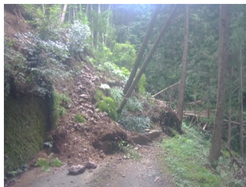
市道被害（窪野地区）
