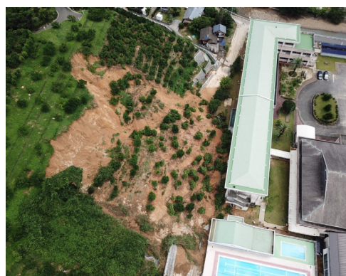
急傾斜地の崩壊（俵津：下ノ谷地区）
