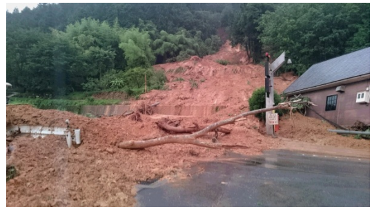
国道 197 号被害（高野子）
