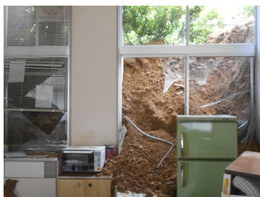
明浜中学校（内部）
