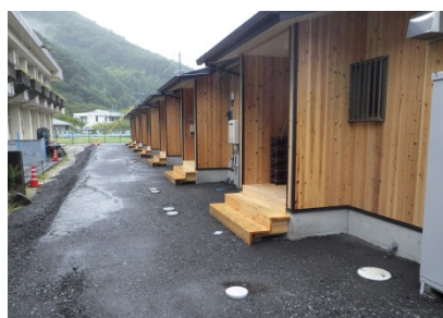
明間地区応急仮設住宅(建設型)
