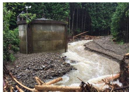
宇和上水道下川配水池付近
