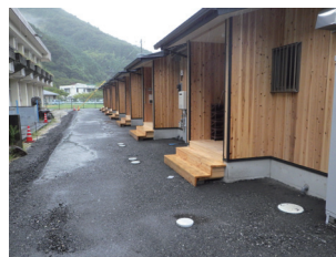
明間地区応急仮設住宅（建設型）
