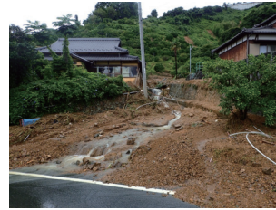
土砂の流出 (俵津：脇川)
