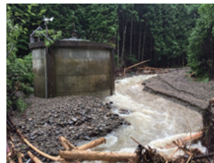
宇和上水道下川配水池付近
